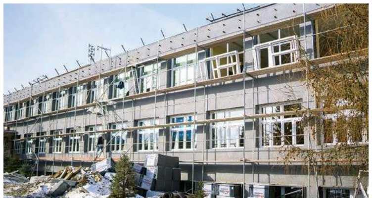
Nowe okna i ocieplone elewacje zapewnią komfortowe warunki uczniom i nauczycielom
