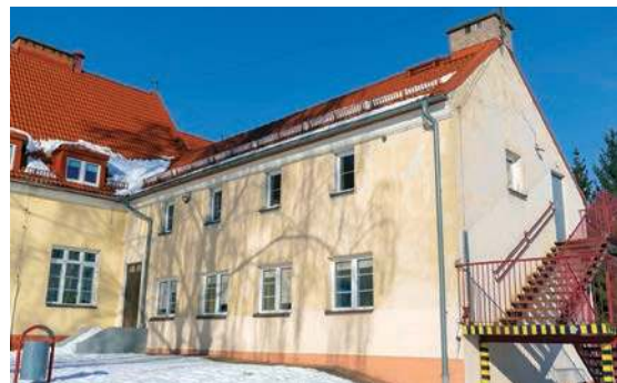
Budynek SP nr 6 przy ul. Wiklinowej - stan obecny
