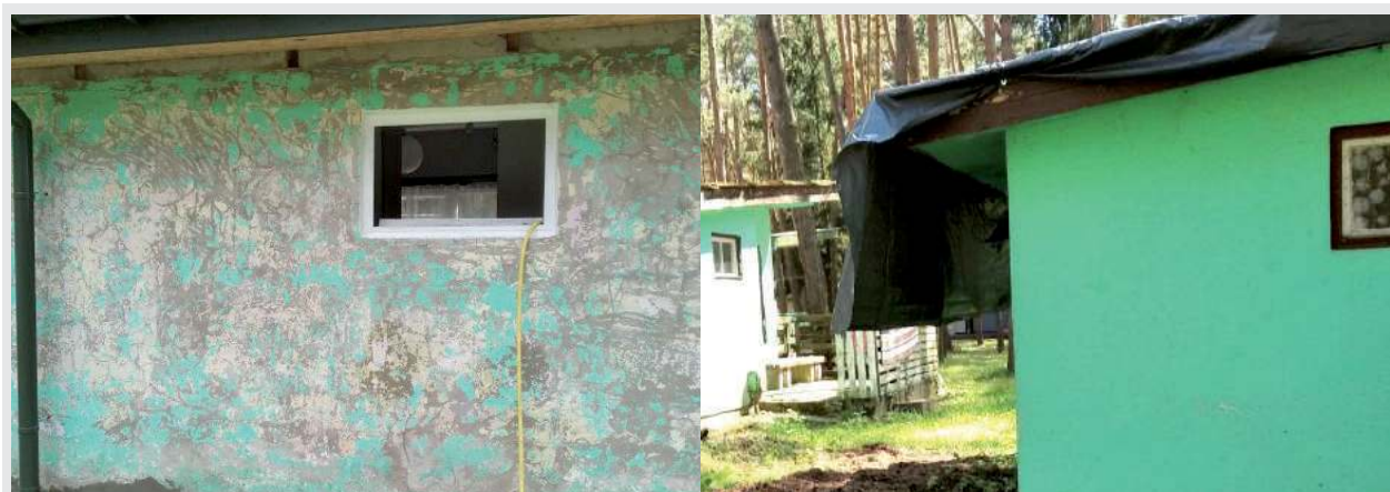
Tak wyglądał domek przed remontem...
