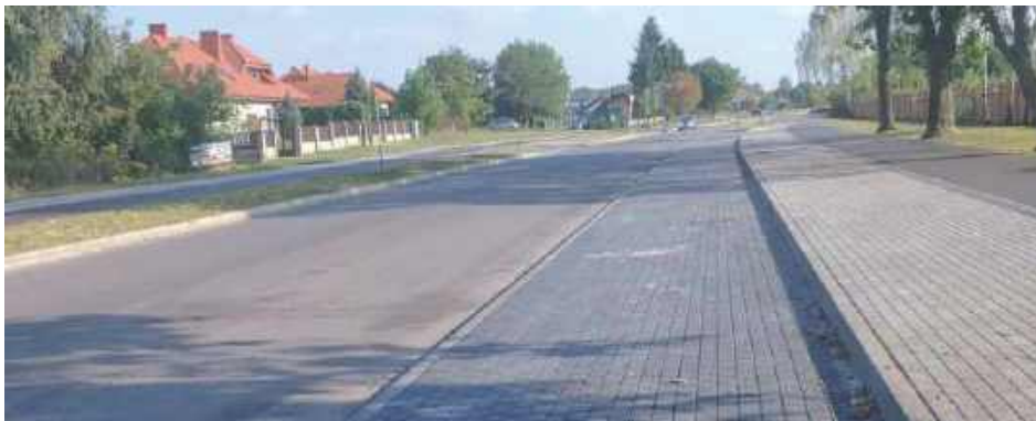
W ramach przebudowy al. Zwycięstwa powstały m.in. zatoki postojowe
