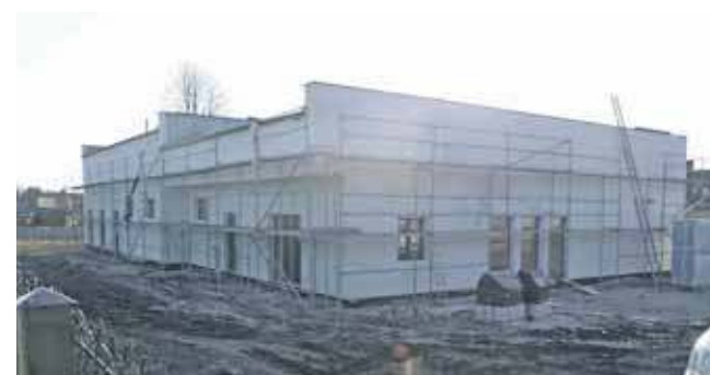
Poza stanowiskami na wozy w budynku będzie też sala szkoleniowa, sanitariaty i gabinet zarządzającego jednostką
