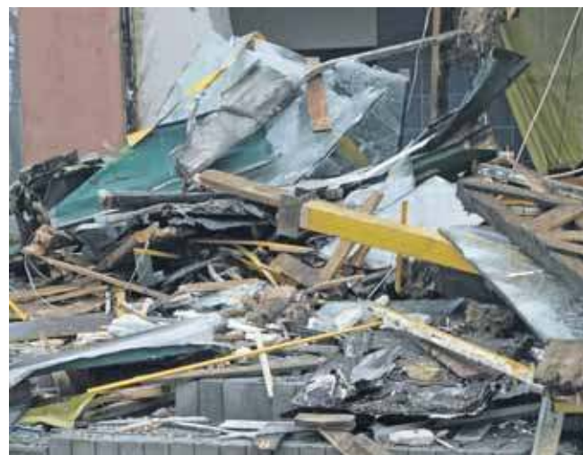
Po uporządkowaniu terenu mają ruszyć prace związane z budową ścieżki rowerowej
