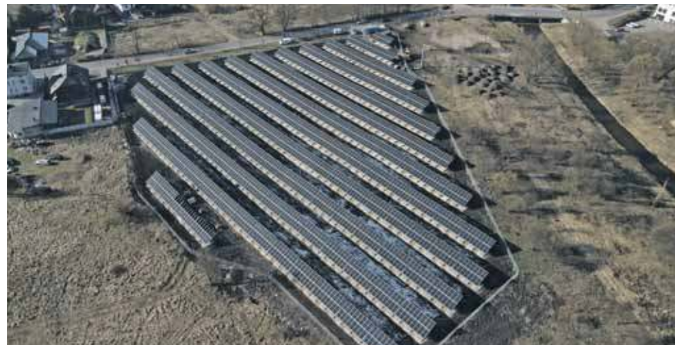
W Kaletach powstaje duża instalacja fotowoltaiczna
