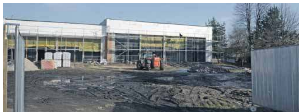
Tak od frontu wygląda budowana remiza OSP Kalety
