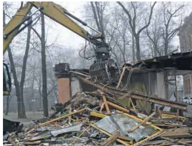
Ciężki sprzęt szybko poradził sobie z rozbiórką dawnej kwaciarni
