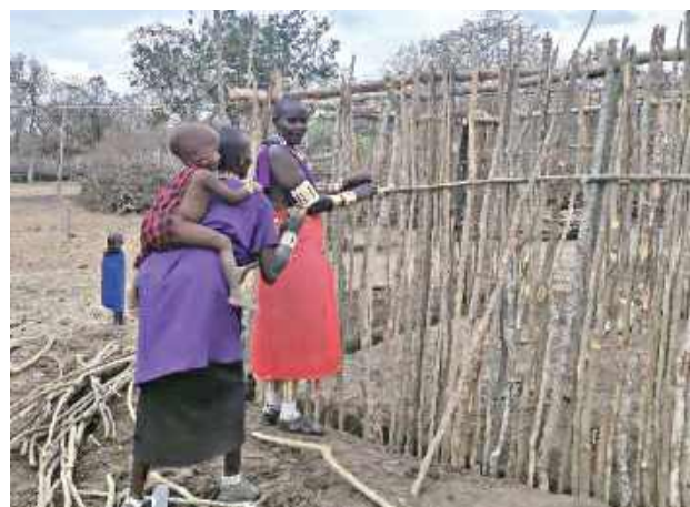
Budowa „domu tymczasowego” dla rodziny Karena. Ich obecny dom grozi zawaleniem
