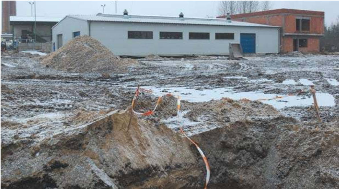
Powstaje nowy budynek biurowo-socjalny. Hala po lewej mieści linię do regranulatu, która czeka na pozwolenie na uruchomienie produkcji
