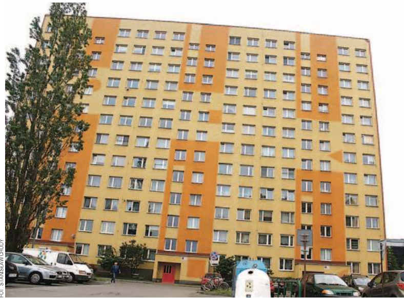
Wieżowiec przy ul. Okulickiego 4 będzie pierwszym, gdzie w ramach projektu „Ekomiasto Stalowa Wola” zostaną zlikwidowane gazowe termy
