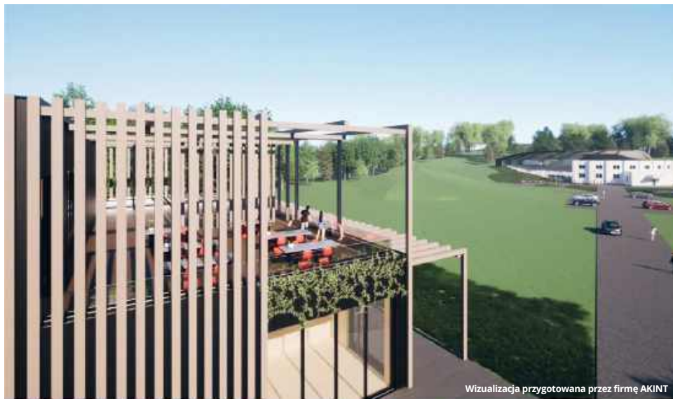
WIDOK NA BUDYNEK USŁUGOWY - TARAS RESTAURACYJNO-REKREACYJNY
