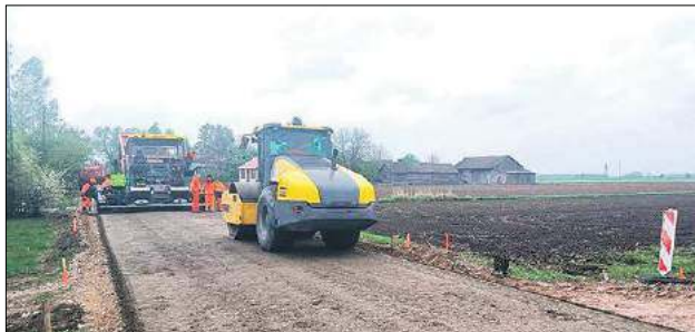
Do końca maja zostaną dokończone cztery odcinki dróg
