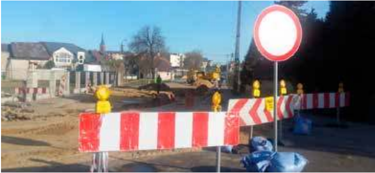
Na stoczkowskim odcinku drogi krajowej nr 76 trwają prace remontowe.
