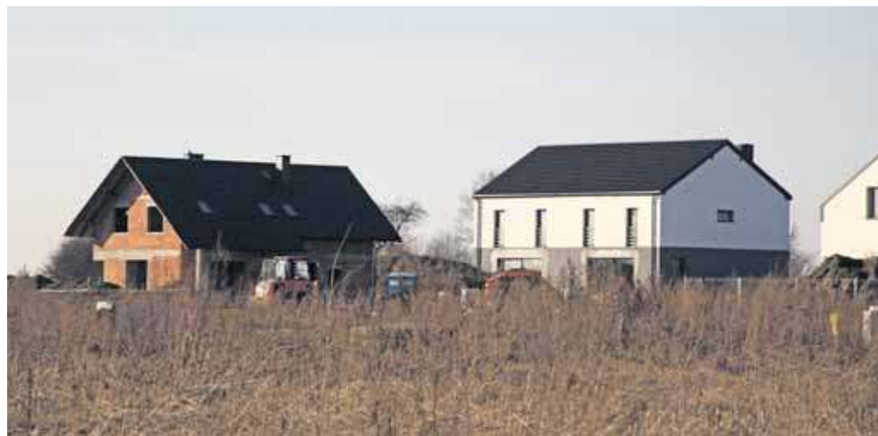
Nowe domy powstają na osiedlu Sielanka
