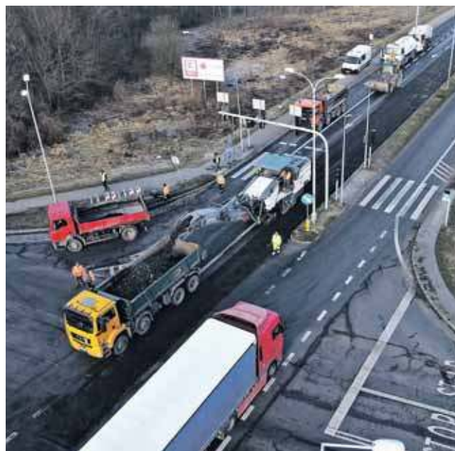
Drogowcy remontują obwodnicę w Tarnowskich Górach
