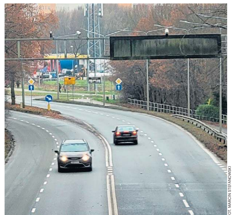
Na wjeździe do Koszalina nadal można zobaczyć elementy poprzedniego systemu. Ciągłe trwa proces sądowy z wykonawcą
