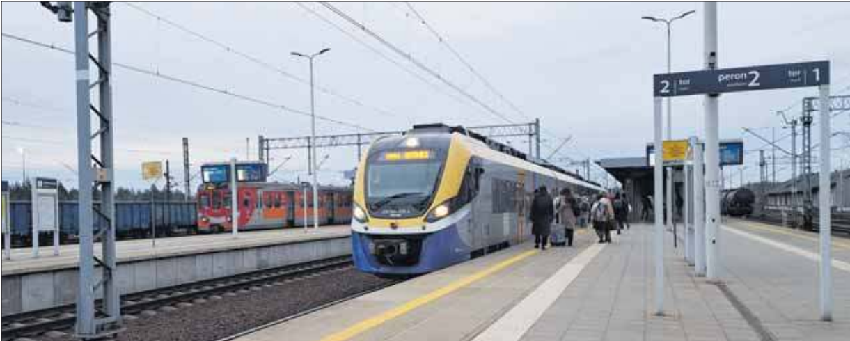
Modułowe poczekalnie mają powstać na dwóch peronach na dworcu Jaworzno Szczakowa (fot. Patrycja Koprzak)
