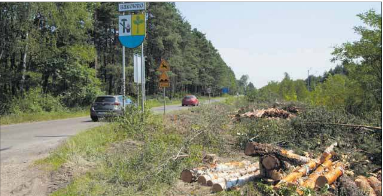
Trwa wycinka drzew, które kolidują z planowaną rozbudową drogi z Jaworzna do Bukowna (fot. Patrycja Koprzak)
