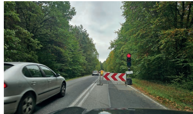
Rozkopana droga wojewódzka 791, niedaleko za Myślachowicami w stronę Olkusza
