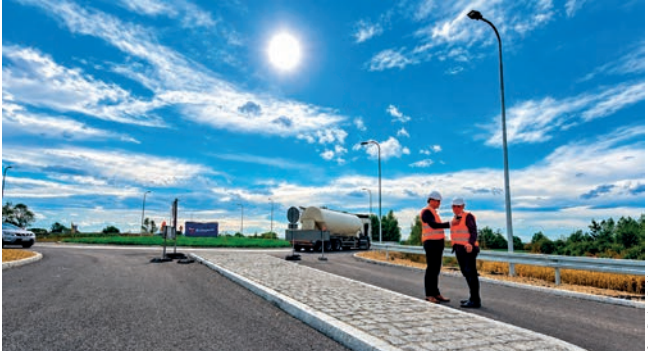
Budowa obwodnicy Olszyn i Jankowic dobiega końca
