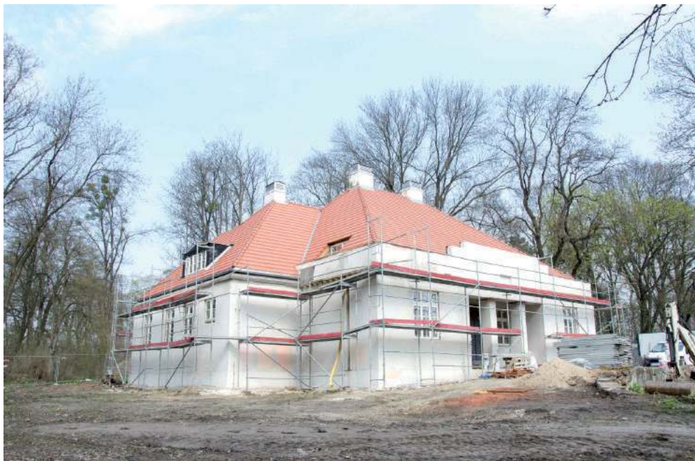
Pokrycie dachu dworu wykonano z dachówki ceramicznej „karpówki”, której jedną zaledwie sztukę znaleziono na poddaszu
