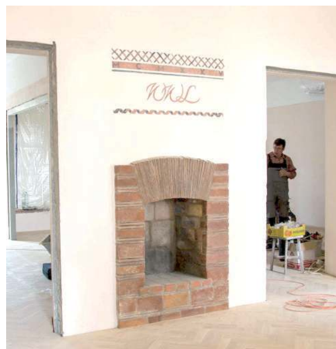
Prace remontowe odkryły nad kominkiem sgraffitowy ornament z datą powstania dworu MCMXXV (1925) i inicjałami właścicieli W.W.L. (Wanda i Witold Lachert) oraz inicjałami autorów dekoracji B.L. (Bohdan Lachert) i J.S. (Józef Szanajca) ukrytymi w dolnej listwie ornamentu. Sgraffito - wykonane w kolorach czarnym, czerwonym oraz warstwą wierzchnią w naturalnym kolorze tynku - zostało oczyszczone z nawarstwień i wzmocnione. Uszkodzone fragmenty uzupełniono tynkiem barwionym do oryginalnych kolorów
