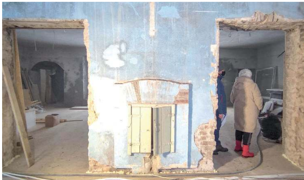
W hallu wejściowym przeprowadzono konserwację ceramicznego kominka, który został wtórnie przekształcony w szafkę wewnętrzną, obudowany drzwiczkami, otynkowany i pomalowany. Usunięto drzwiczki, warstwę tynku i wymalowań z ceglanych partii kominka oraz wtórne, nieprawidłowo wykonane naprawy i przemurzenia. Następnie wykonano uzupełnienia uszkodzeń i ubytków wraz ze spoinowaniem i wzmocnieniem strukturalnym i scaleniem kolorystycznym - czytamy w opisie prac
