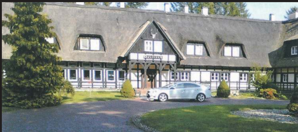
Łańsk - budynek główny - wrzesień 2017
