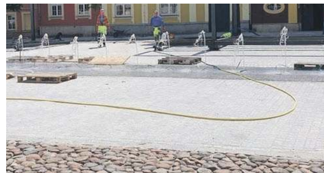
Pierwsze próby instalacji wodnej
