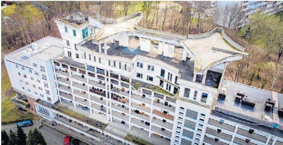
Część nadbudowy została już rozebrana
