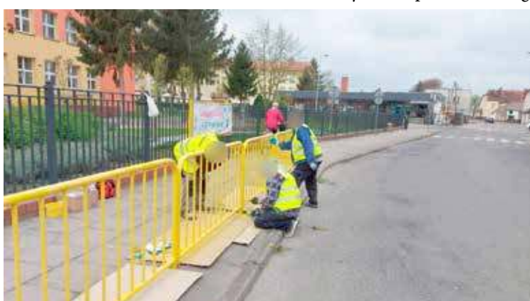
Być może malowanie barierek i wcześniejsze latanie dziur to jedyne prace jakie zostały podjęte na ul. St. Żeromskiego w tym roku
