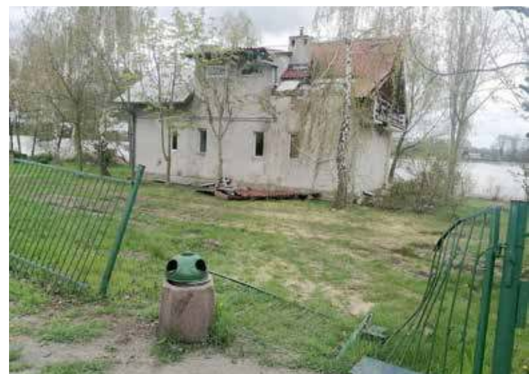
Olbrzymia wyrwa w płocie po drzewie, które na początku roku uszkodziło domek przy plaży
