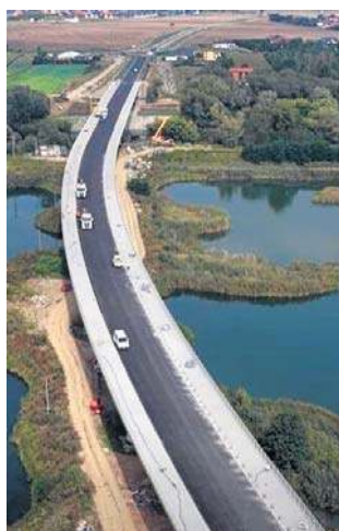
Budowa drugiego mostu na Sanie pod Jarosławiem zbliża się do zakończenia
