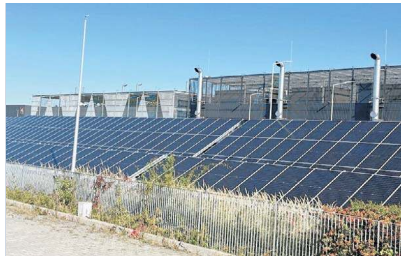
Przy nowym obiekcie pojawiła się cała farma fotowoltaiczna, ale nie wiadomo kiedy budynek zacznie w pełni służyć resortowi finansów.
