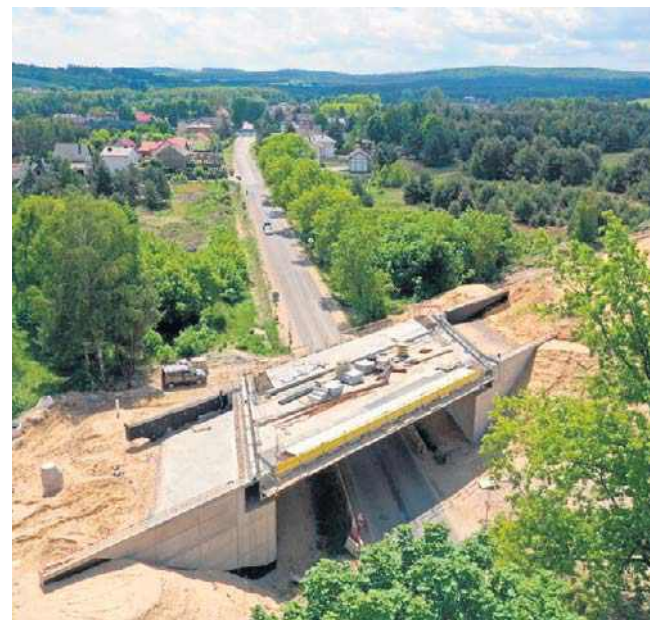
Budowlancy nie mają wakacji, tempo pracy imponuje
