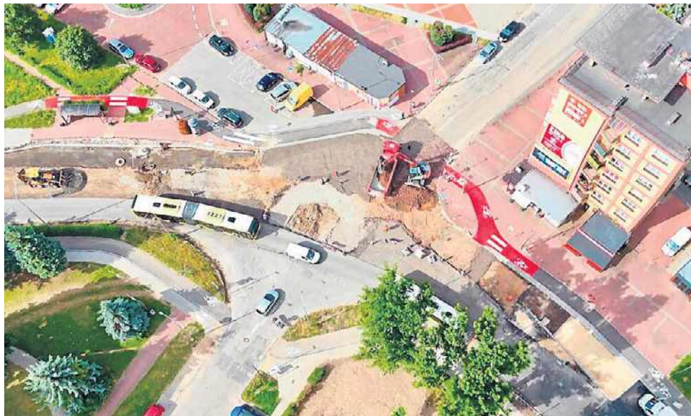
Na skrzyżowaniu ulic Wybickiego, Wiśniowej, Prusa i Tierszkiej trwa budowa ronda. Ulice Wybickiego i Wiśniowa pokryje też nowa warstwa asfaltu
