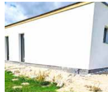
W miniony wtorek zakończył się kolejny etap prac przy budowie świetlicy wiejskiej w Nowej Dąbrowie
