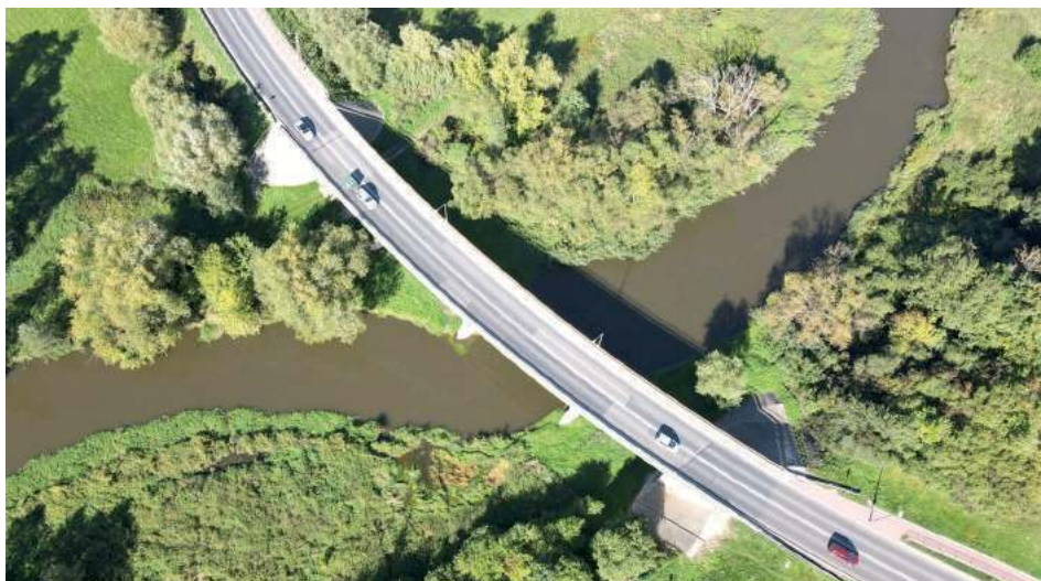
Nowy most nad rzeką Wieprz powstać ma obok istniejącego, wybudowanego w 1966 roku i będącego już w złym stanie technicznym. Zostanie wybudowany po lewej stronie, jadąc od Lublina. Konstrukcja mostu będzie przystosowana do obciążeń do 50 ton
