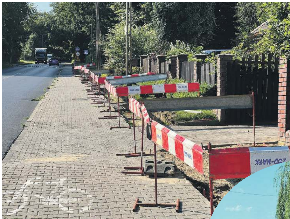
Tak wygląda fragment ścieżki rowerowej w Trzebnicy. Tymczasem burmistrz Marek Długozima zapewniał, że ścieżki wykonano prawidłowo. Dlaczego gmina wydaje dodatkowe pieniądze na ich poprawę?
