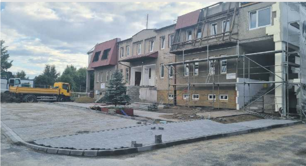
Prace remontowe ośrodka zdrowia z Zawoni przebiegają zgodnie z planem.
