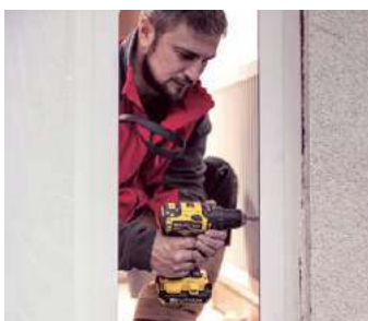
➏ Przytwierdzenie wkrętami ramowymi aluminiowej ramy doświetla do ściany budynku.
