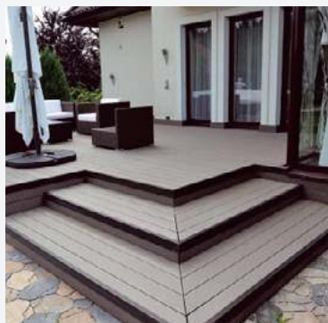
🔊 Krawędzie podestu i schodów wykończono listwami z kompozytu.
