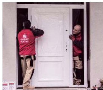
➌ Pozycjonowanie skrzydła drzwi z ramą doświetli w otworze ściany budynku.
