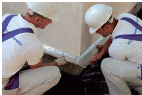
🔴 Początek robót – mocowanie listwy startowej z aluminium lub ocynkowanej stali. ATLAS
