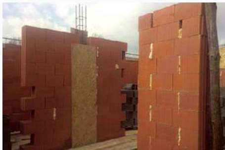
❶ Wypełnienie spoin pionowych pianką poliuretanową jest błędem. T. RYBARCZYK
