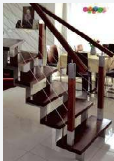
🔗 Zabiegowe schody wykonano ze stali nierdzewnej i drewna merbau.
