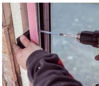
➎ Mechaniczne mocowanie ramy doświetla do profilu bazowego wkrętami ramowymi.
