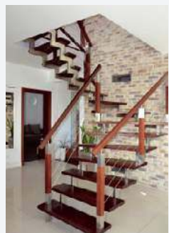
🔗 Zabiegowe schody wykonano ze stali nierdzewnej i drewna merbau.
