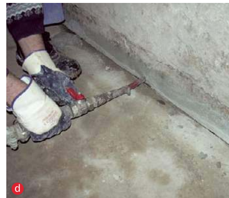
❶ Odtworzenie izolacji poziomej może wymagać: podcicia ścian specjalną piłą (a); ułożenia w szczelinie nowej warstwy uszczelniającej z papy (b); wbicia klinów w szczelinę (c); wypełnienia jej zaprawą pod ciśnieniem (d). PRINZ
