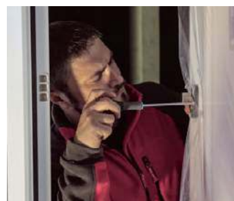
➑ Osadzenie szyldów w skrzydle drzwi.
