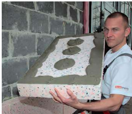
🔴 Zaprawę klejącą nanosi się na płyty, nie na podłoże. TERMO ORGANIKA
