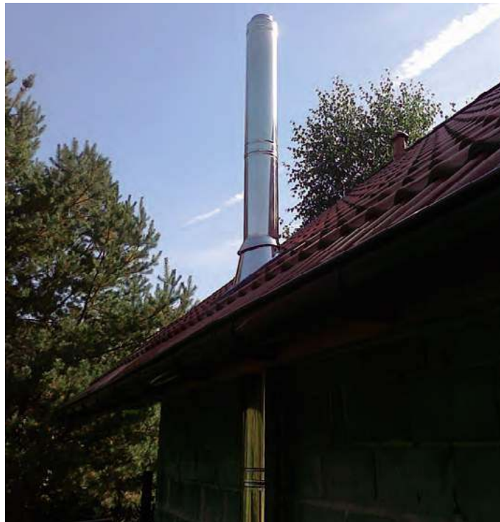
❷ W remontowanych domach chętnie stosuje się komin-y zewnętrzne, bo w ten sposób unikamy przebijania się przez stropy. Nie psujemy też ustawności pomieszczeń. KOMIN-FLEX
