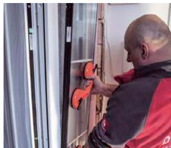
➓ Zamontowanie pakietów szybowych w aluminiowych ramach doświetli.
