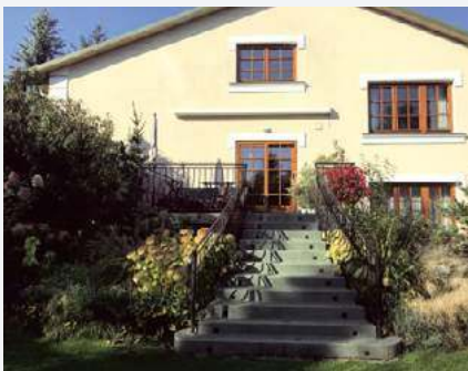
Najnowsze schody ogrodowe wyposażone w oświetlenie LED w podstopnicach.
