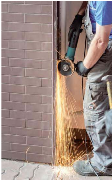
🔧 Usuwanie niepotrzebnych elementów starej stalowej ościeżnicy. NOVOFERM
