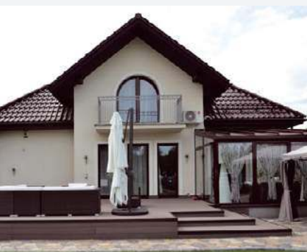
🔊 Rozległy podest o wysokości 46 cm wykonano z kompozytu.
