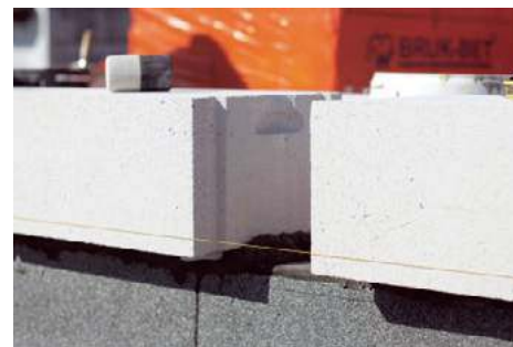
❗ Bloczki z betonu komórkowego różnią się gęstością i wymiarami. Najlżejsze wykorzystuje się na ściany jednowarstwowe, a najcięższe – na dwu- i trójwarstwowe. BRUK-BET (TERMALICA)
