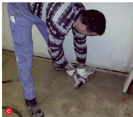
❶ Odtworzenie izolacji poziomej może wymagać: podcicia ścian specjalną piłą (a); ułożenia w szczelinie nowej warstwy uszczelniającej z papy (b); wbicia klinów w szczelinę (c); wypełnienia jej zaprawą pod ciśnieniem (d). PRINZ
