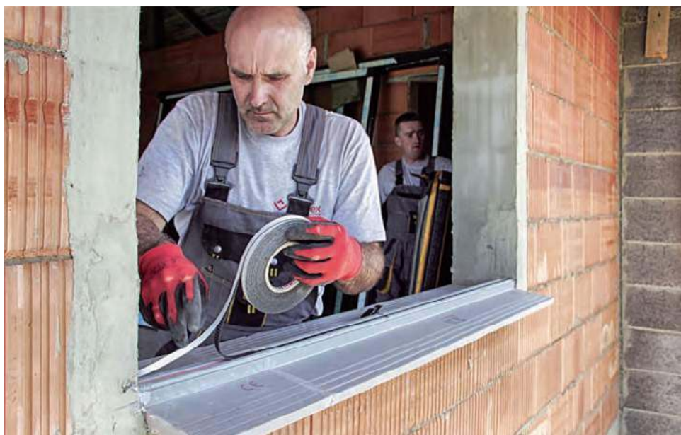
🔧 Tzw. ciepły parapet, na którym stawia się okno, eliminuje przedmuchy i mostki termiczne. VETREX
