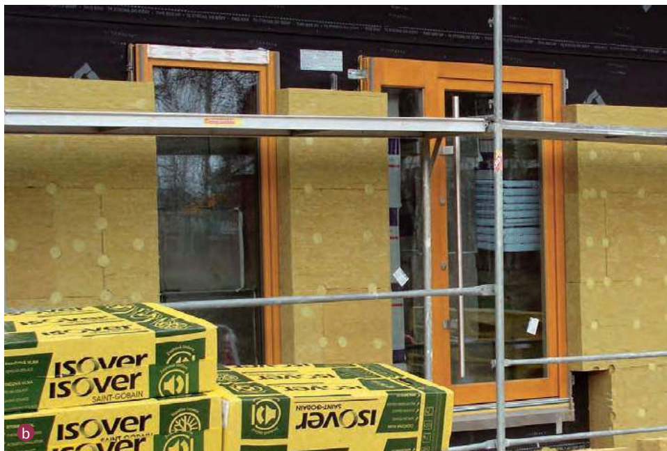
🔑 Dwa najpopularniejsze materiały ociepleniowe: styropian, tu w wersji grafitowej (a STYROPMIN) i wełna (b ISOVER).
