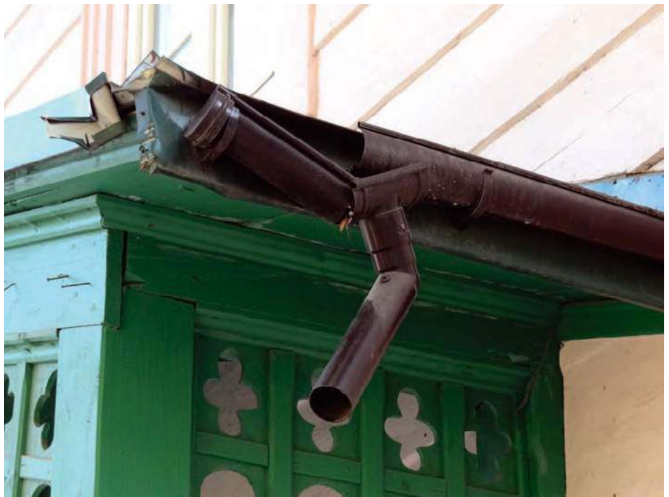
🔧 Remont dachu do doskonała okazja do wymiany przedziewiałych lub potamanych rynien. GALECO
