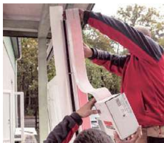
➋ Oklejenie ramy aluminiowej doświetli taśmami do montażu warstwowego.
