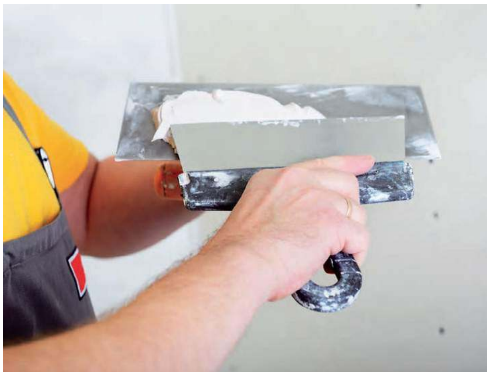
Remontowane ściany zwykle wyrównujemy gładzią, a następnie malujemy. BAUMIT, ŚNIEŻKA
