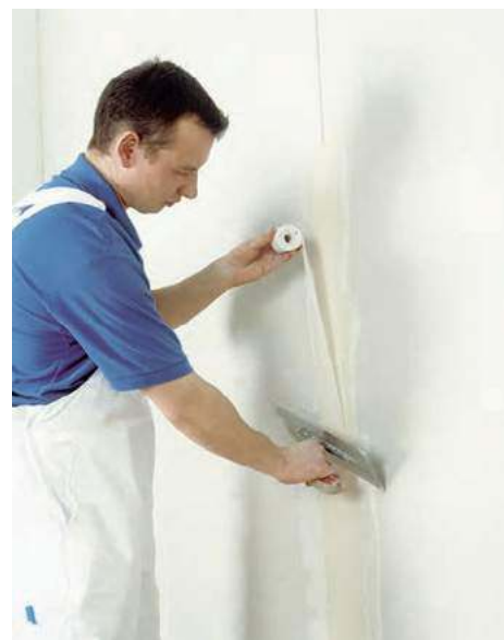
Wykańczanie miejsc połączeń płyt poprzez wtopienie taśmy zbrojącej w masę szpachlową. KNAUF
