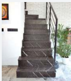
Zabiegowa klatka schodowa została wykończona płomieniowanym marmurem.
