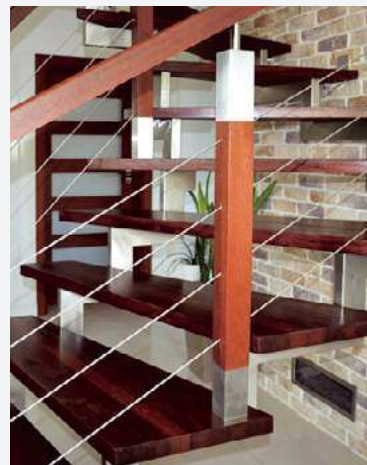
❗ Elementy mocowania stalowej konstrukcji, balustrady z linkami.
