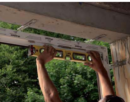
🔧 W ścianach warstwowych okna można montować, wysuwając je w warstwę ocieplenia. ALUPLAST
