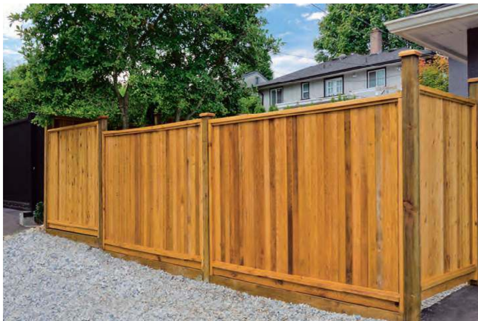
🔩 Płoty drewniane, choć piękne i naturalne, najszybciej ulegają tzw. korozji biologicznej i bezwzględnie muszą być zabezpieczone przed wilgocią oraz grzybami. VIDARON
