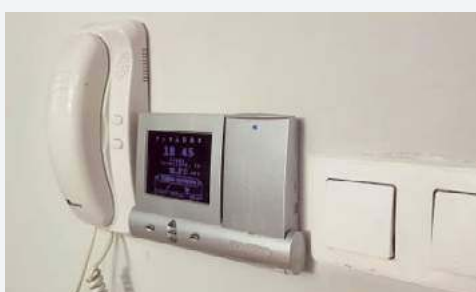
📞 Domofon ze słuchawką oraz manipulator alarmu umieszczono w wiatrołapie.
