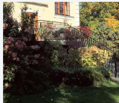
Wszystkie schody mają stalowe balustrady z wybruszeniem.
