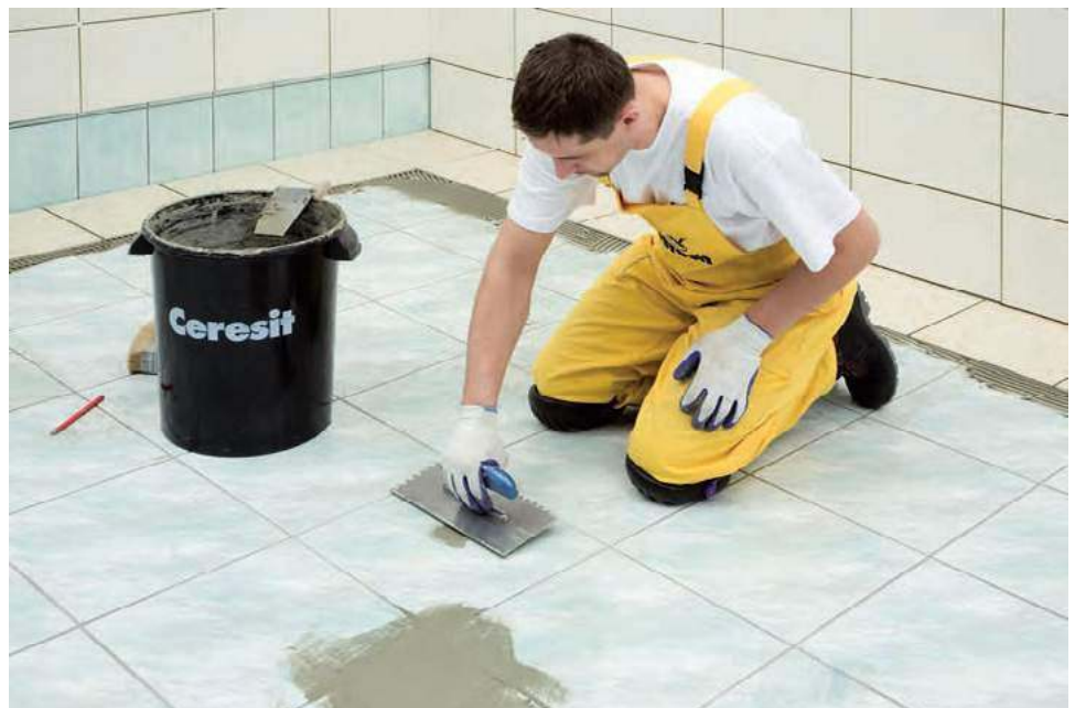
Pojedyncze zagłębienia w podkładzie ze starej terakoty należy zaspachlować zaprawą wyrównującą. CERESIT
