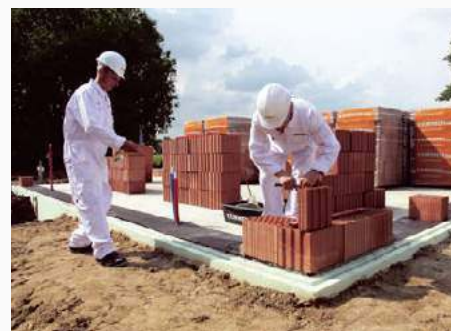
📌 Prawidłowo wykonane murowanie ścian zaczyna się narożników, a następnie ustawia się kolejne elementy. ZCB OW CZARY
