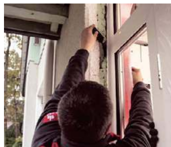
➍ Zablokowanie ramy doświetla z drzwiami klinami montażowymi, z zachowaniem poziomu nadproża i geometrii stolarki aluminiowej.
