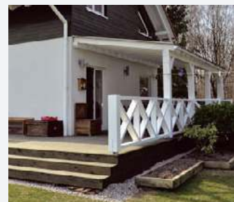
➌ Podest o wymiarach 7,7 x 4 m rozbudowano o 18 m 2 (3 x 6 m).
