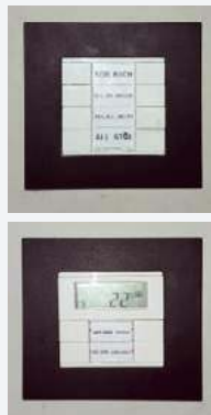
❸ Łączniki, również z wyświetlaczem temperatury.
