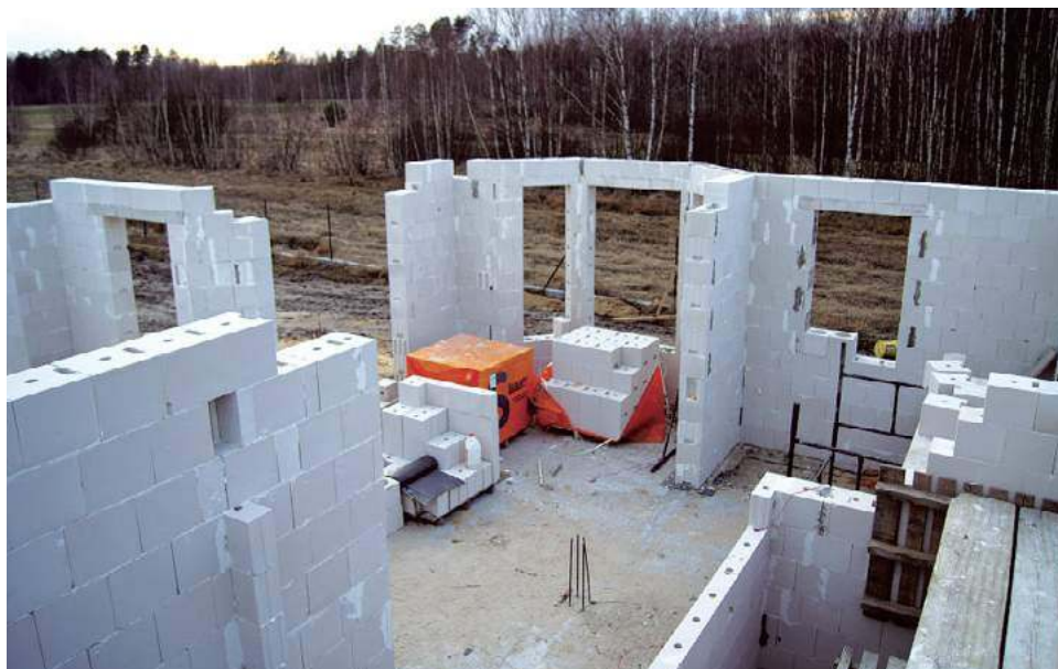
📌 Elementy wapienno-piaskowe mają wysoką zdolnością tłumienia dźwięków i akumulacyjność ciepła. GRUPA SILIKATY
