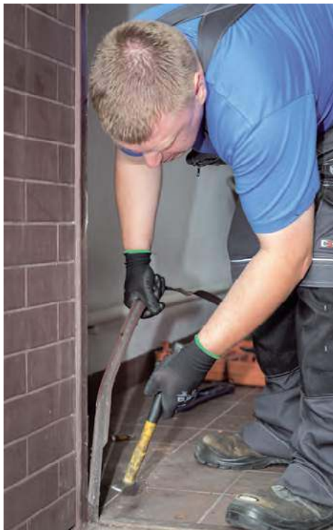
🔧 Usuwanie niepotrzebnych elementów starej stalowej ościeżnicy. NOVOFERM
