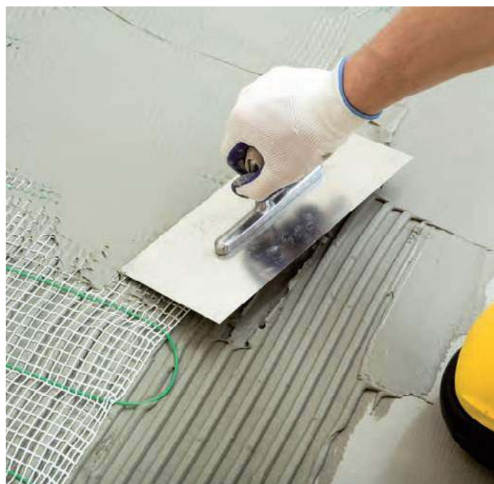
Umieszczanie maty grzejnej w warstwie kleju pod płytkami. CERESIT
