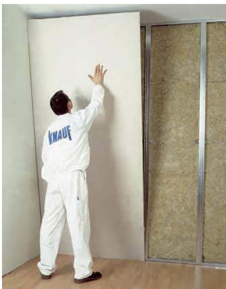
Montaż płyt gipsowo-kartonowych na profilach umożliwia umieszczenie w ścianie izolacji z wełny mineralnej. KNAUF
