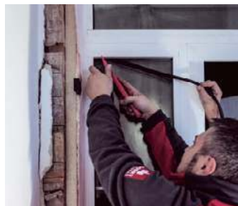
➒ Montaż uszczelek w ramkach przyszybowych doświetli drzwi.
