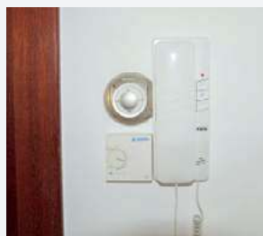
➔ Przy unifonie zamontowano przycisk do otwierania bramy wjazdowej.
