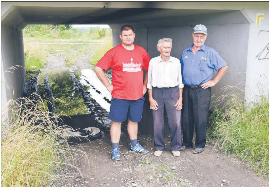
Od lewej na zdjęciu Marcin Bieniasz, Kazimierz Sulisz oraz Zygmunt Kopala przy problematycznym wiadukcie.
