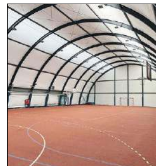
Zespół Szkół nr 2 w Łosicach uzyskał dofinansowanie na budowę zadaszenia boiska
