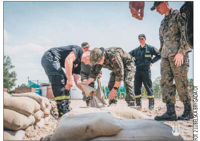
Żołnierze poznali też zasady budowania wałów przeciwpowodziowych
