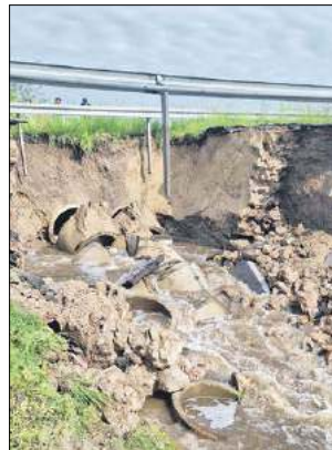
Remont drogi ma potrwać około miesiąca
