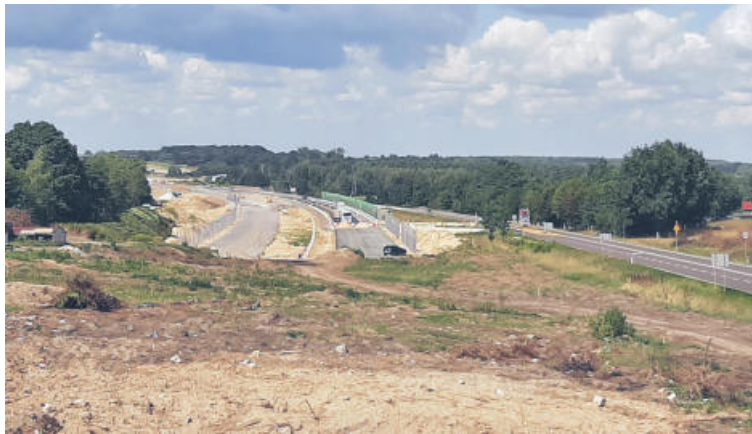
Budowa autostrady trwa.
