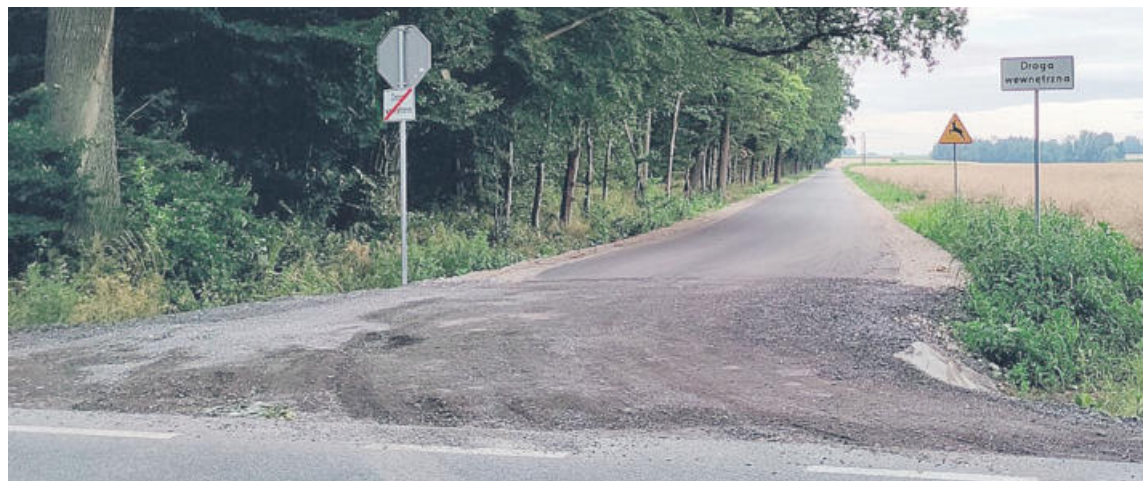
Była droga gruntowa, jest asfaltowa, czyli mała obwodnica...
