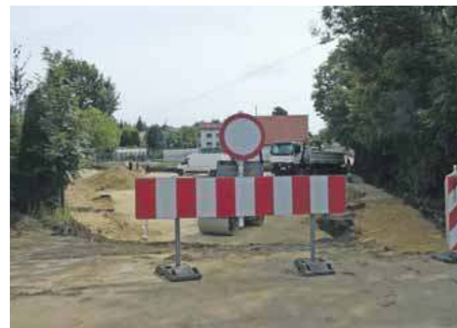
W Bobrownikach Śląskich budują łącznik pomiędzy ulicami Jemiołową i Przedwiośnia
