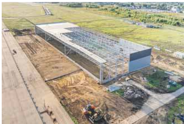
Hangar ma być gotowy w pierwszym kwartale przyszłego roku
