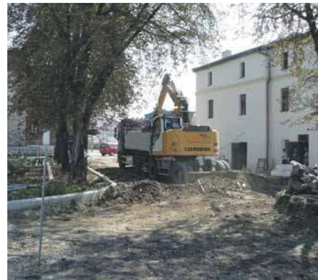
W ramach inwestycji m.in. przebudowany będzie zamknięty dziś fragment ul. Królika do Dolnej oraz ukończona nawierzchnia placu, na którym była synagoga
