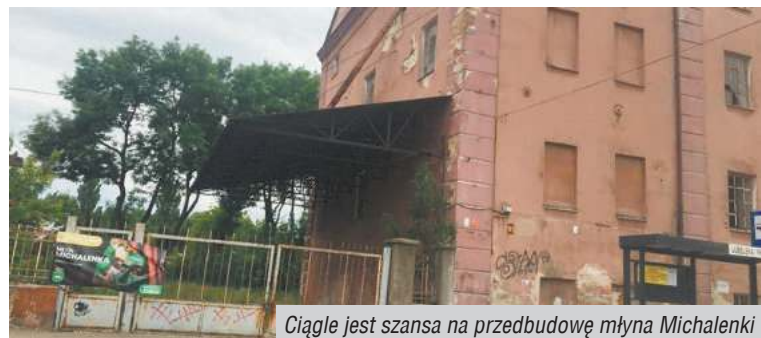
Ciągle jest szansa na przebudowę młyna Michalenki
