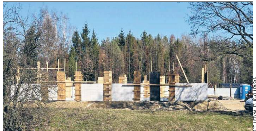
Prace budowlane są w toku, a po ich zakończeniu rozpocznie się proces adaptacji wnętrza budynku
