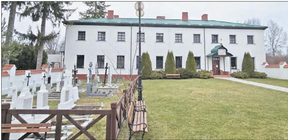
Dach na budynku klasztoru wymaga natychmiastowego remontu
