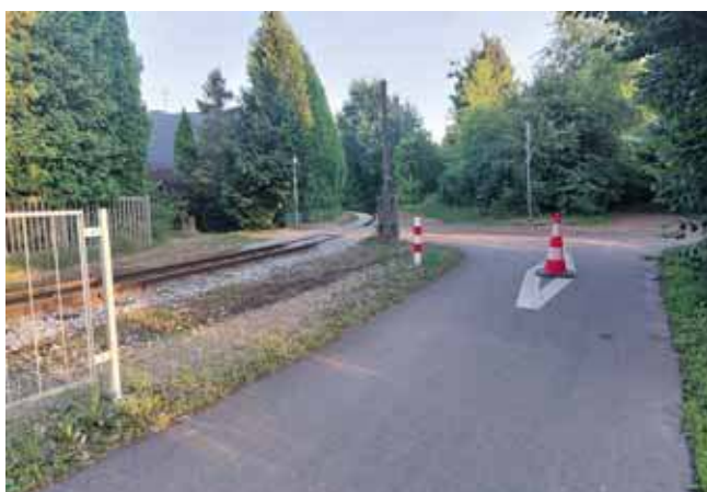
Powstanie brakujący 3-kilometrowy odcinek drogi rowerowej wzdłuż wąskotorówki – od ul. Parkowej do granicy z Bytomiem
