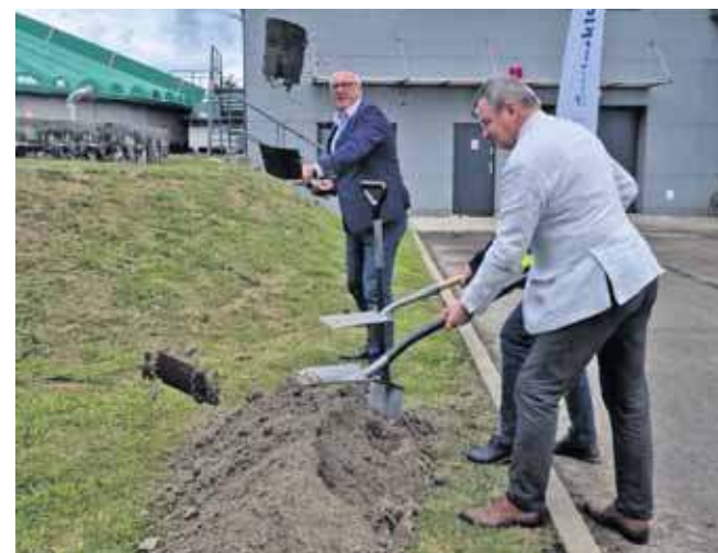
Budowa oczyszczalni oficjalnie rozpoczęta
