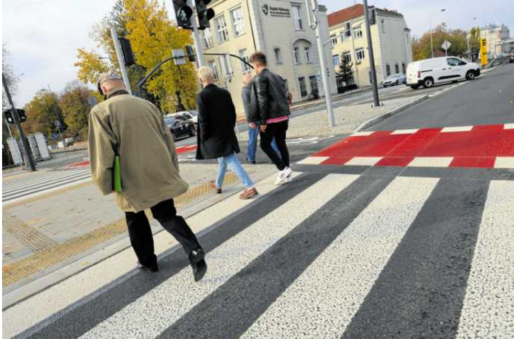
• Przejsie i przejazd rowerowy łączące ul. Karową z kładką pieszo-rowerową nad Wisłą, 30.10.2024 r.
