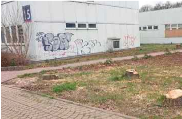
Budynki po urzędzie miasta czekają na pozwolenie na rozbiorę
