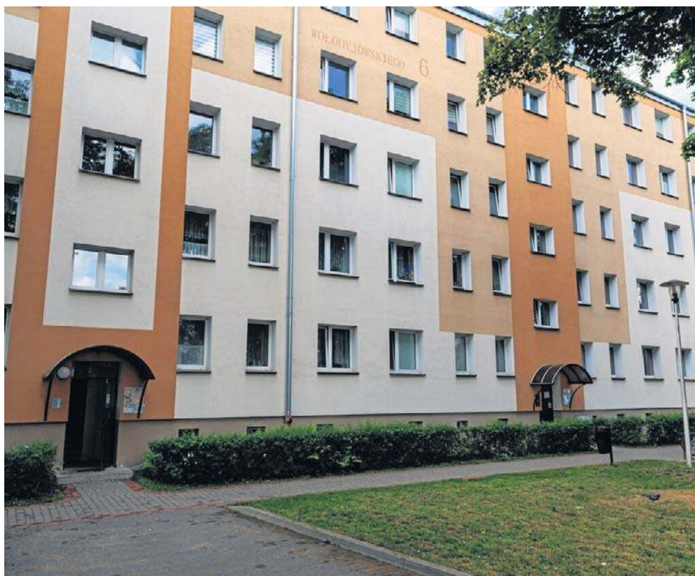
Jeden z pięciokondygnacyjnych bloków na osiedlu Piaski. Takich budynków w Białymstoku jest wiele. Osoby starsze czy z niepełnosprawnością, mieszkające w nich na wyższych kondygnacjach z powodu braku windy mają problemy, aby wyjść na zewnątrz czy wejść do swoich mieszkań
