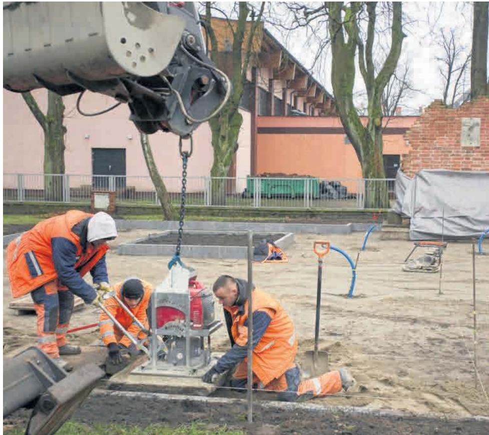
Prace w parku Powstańców Warszawskich wykonywane są w ramach projektu „Łamiemy bariery, łączymy pokolenia - rewitalizacja obszaru Podgrodzia, Starego Miasta i Śródmieścia Miasta Słupska”
