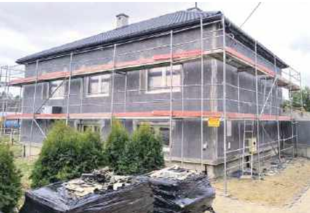
Budynek świetlicy w Borowej przechodzi termomodernizację. Instalacja fotowoltaiczna o mocy 3,24 kW, energooszczędne oświetlenie LED oraz zmodernizowana instalacja centralnego ogrzewania. Efektem będzie poprawa efektywności energetycznej
