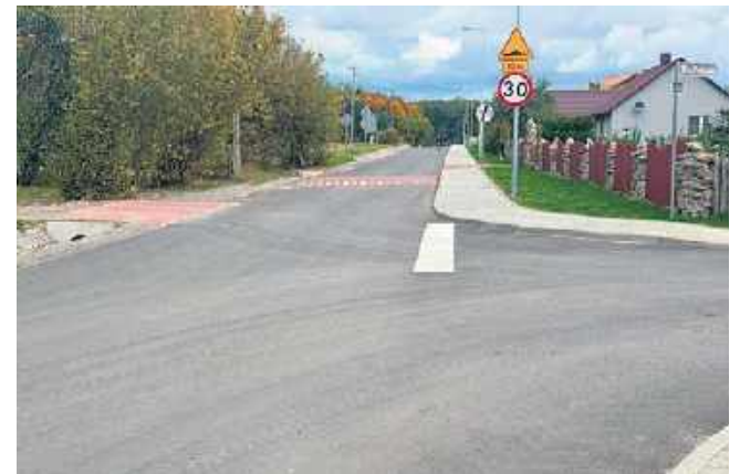
Zmodernizowany został ponad 500-metrowy odcinek drogi
