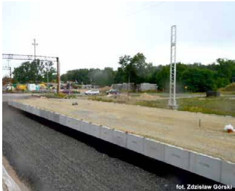
Od poniedziałku 19 kwietnia przejazd kolejowy w Dolicach ponownie zostanie zamknięty
