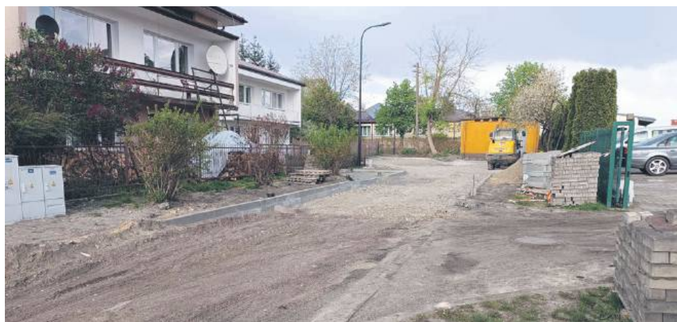
Prace przy ulicy Borowej, Krótkiej, Wierzbowej i Pękalskiego.
