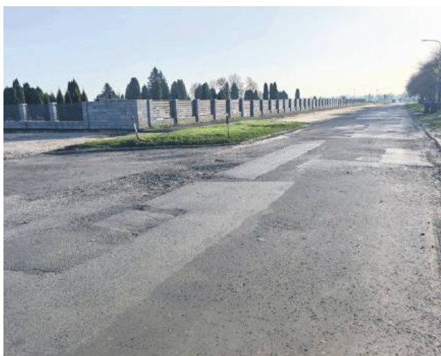
Projekt obejmuje budowę i przebudowę ulic.
