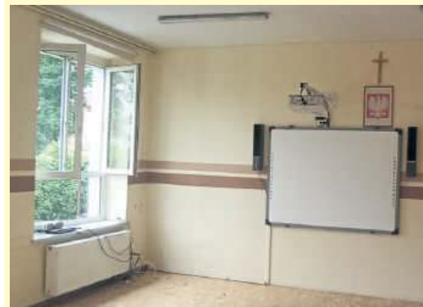
Podłogi w dwóch salach lekcyjnych w Prusach doczekają się remontu
