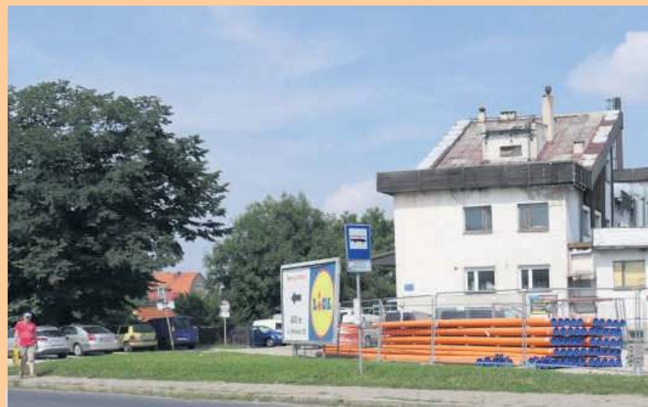
Przy ulicy Wolności w Strzelinie, na parkingu pod restauracją „Sezam”, ustawiono pierwsze materiały potrzebne do remontu tej drogi
