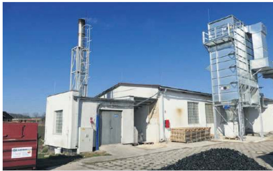
Zamiast tej kotłowni na terenie firmy Kessler ma stanąć nowa na odpady produkcyjne. Foto: archiwum Słowa
