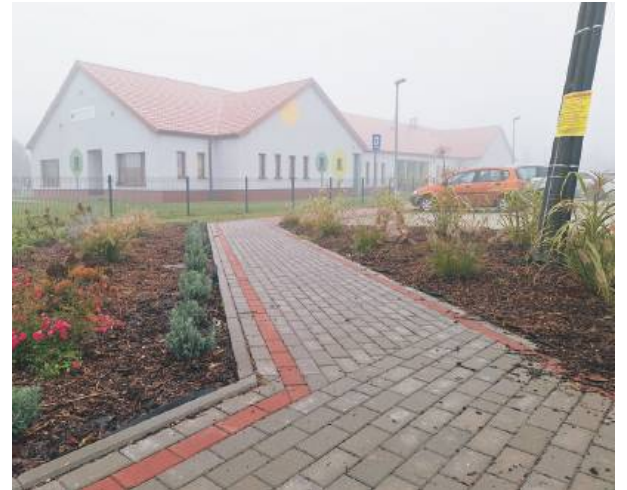
Nowo wybudowany odcinek chodnika, prowadzący do Przedszkola Publicznego w Kondratowicach, poprawił bezpieczeństwo
