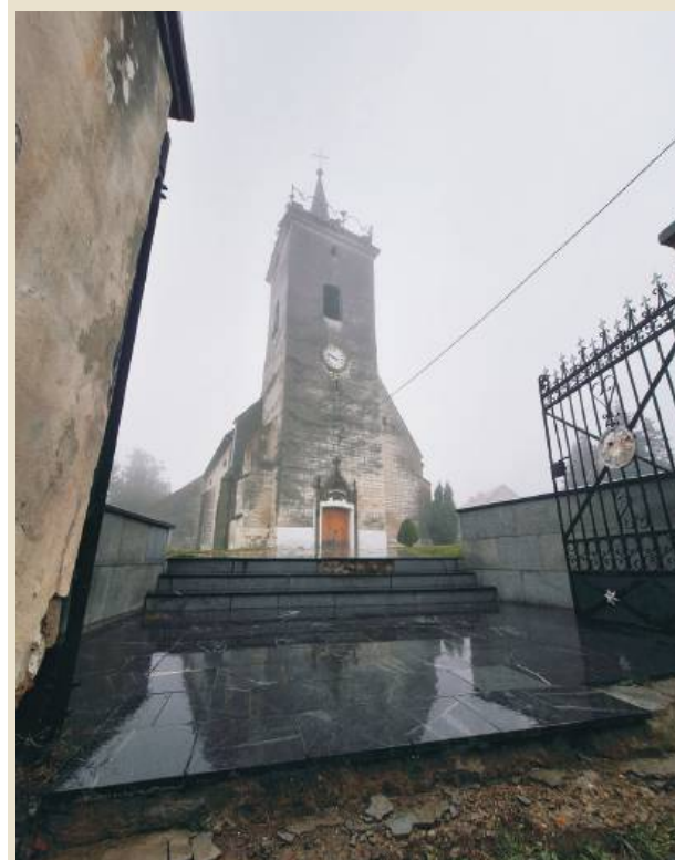
Przy kościele w Prusach wyremontowane zostaną schody zewnętrzne wraz z posadzkami
