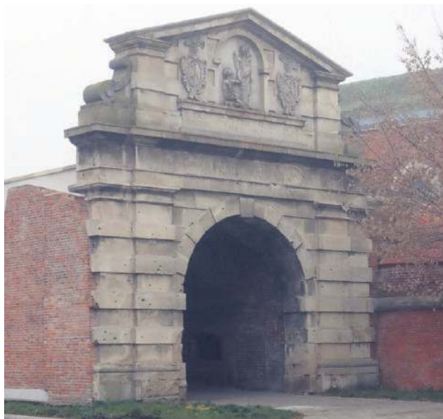
Należy mieć nadzieję, że prace będą kontynuowane. Nietknięta jest m.in. elewacja wschodnia obiektu, wewnątrz bramy też jest jeszcze sporo do zrobienia.
