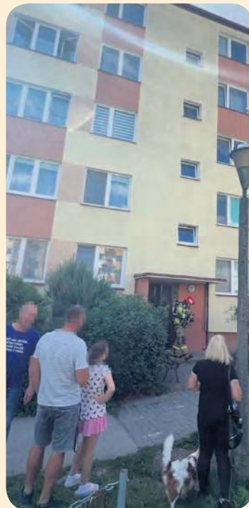
Blok przy ul. Kościuszki w Tucholi. Na klatce schodowej wyczuwalny był swąd spalenizny. W jednym z mieszkań zapaliła się... potrawa w garnku. Fot. (pp)
