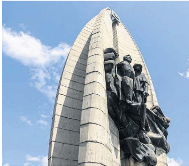
Pomnik wymaga poważnego remontu
