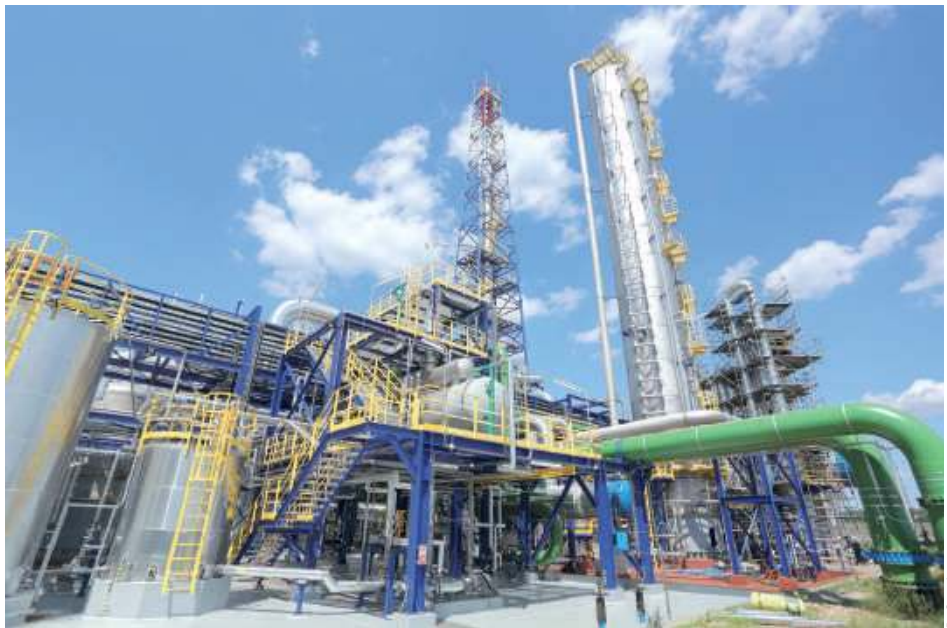
Nowa linia instalacji kwasu azotowego w Puławach jest już gotowa. Trwa rozruch, który zakończy się pod koniec roku
