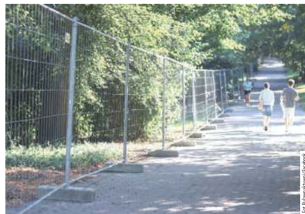
Teren wokół Skweru Niepodległości kilka dni temu został ogrodzony. Prace nad jego modernizacją mają potrwać kilka tygodni
