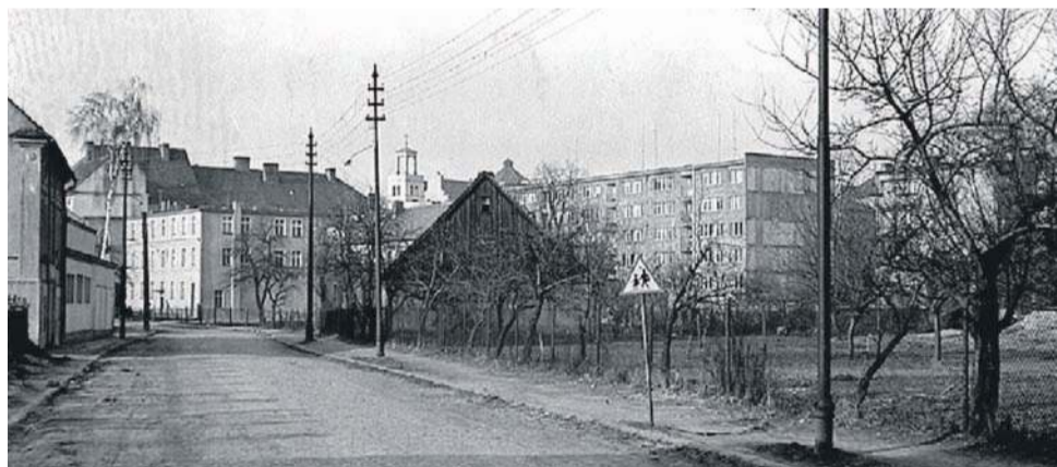
Zdjęcie nr 5 zrobiłem w 1968 na ulicy Lumumby, wcześniej Ogródowej. Od lewej budynek, w którym było przedszkole, dalej budynki, w których były warsztaty szkoły zawodowej. Po prawej na wprost mały budynek mieszkalny, który dziś nie istnieje - tędy biegnie obecnie ulica 11 Listopada. W głębi po prawej nowy wówczas budynek jeszcze nie otynkowany przy ulicy Kościelnej 5-7-9. Zwracam uwagę na oświetlenie uliczne zamontowane na słupie - ten biały kłoz był ze szkła i oławscy chuligani kamieniami rzucałi do tych lamp, zdecydowana większość lamp nie świeciła i miasto dosyć szybko wymieniło to oświetlenie na inne, bardziej odporne na wandalę
