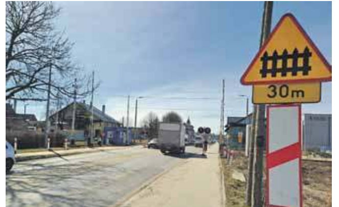
Problematyczny przejazd ma zostać przebudowany. Pozostaje pytanie, czy Ludźmierska pójdzie nad, czy pod torami?
