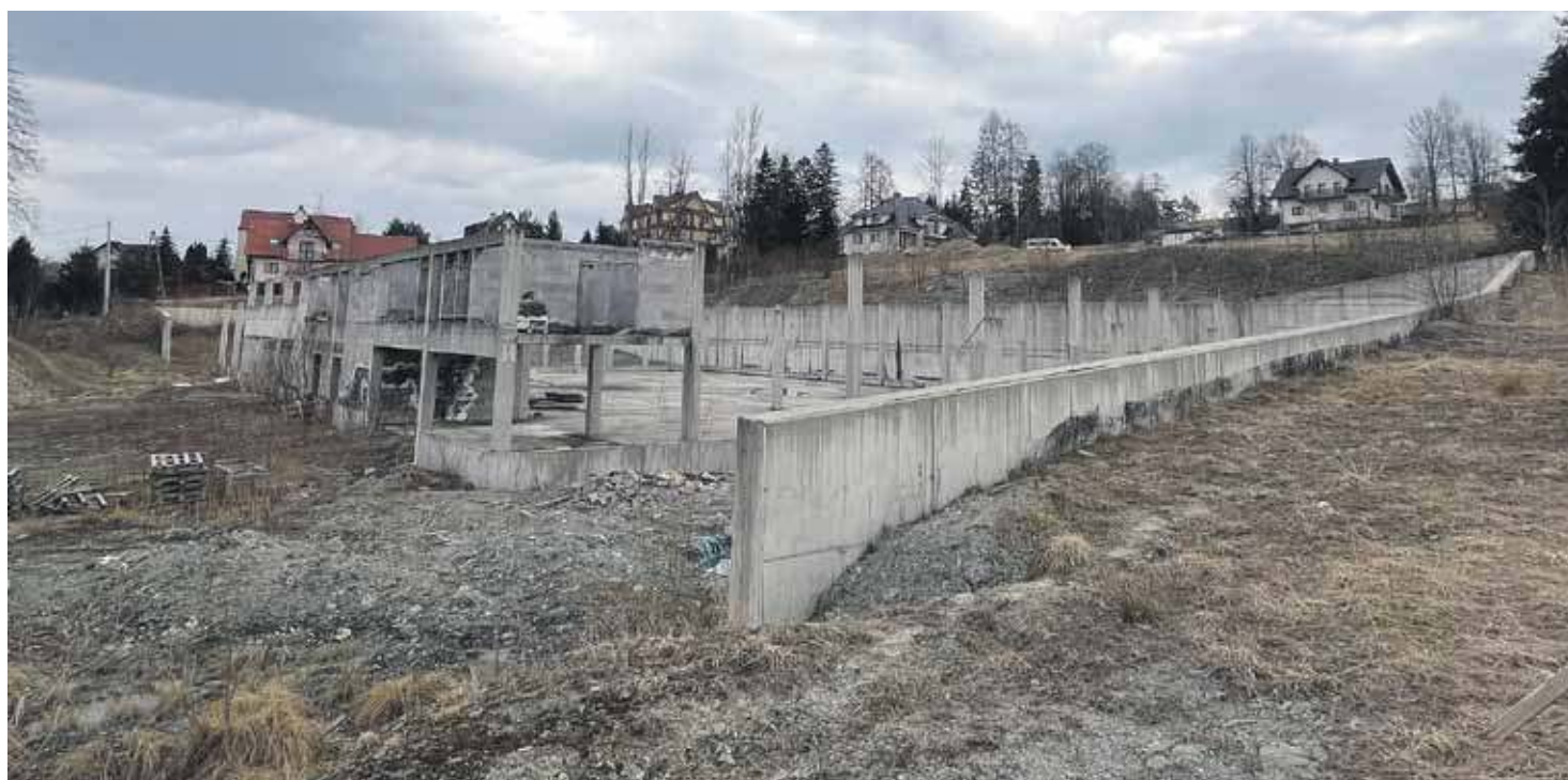
Wstrzymana budowa przy ul. Zakopiańskiej w Rabce.
