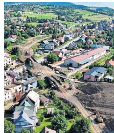
W przyszłym roku pojadą tędy pociągi
