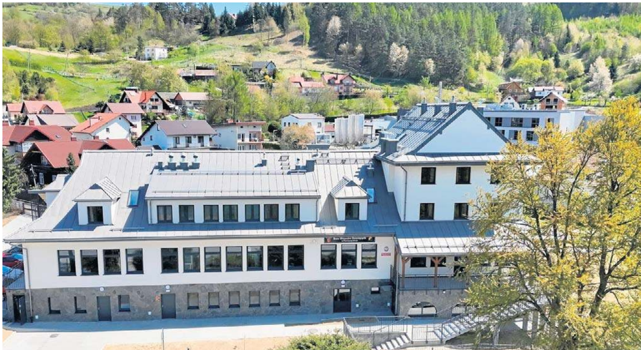
Dom Wczasów Dziecięcych w Piwnicznej-Zdroju przeszedł właśnie gruntowną modernizację wartą ponad 9 mln zł
