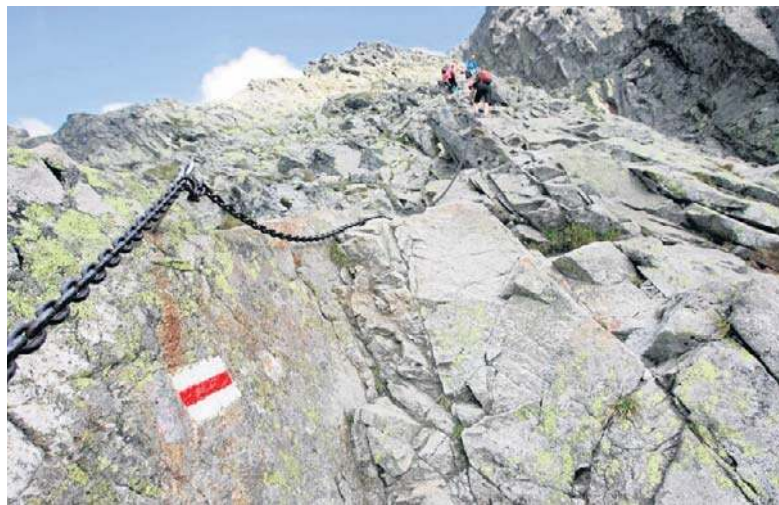
W ramach prac wymienione zostaną łańcuchy asekuracyjne
