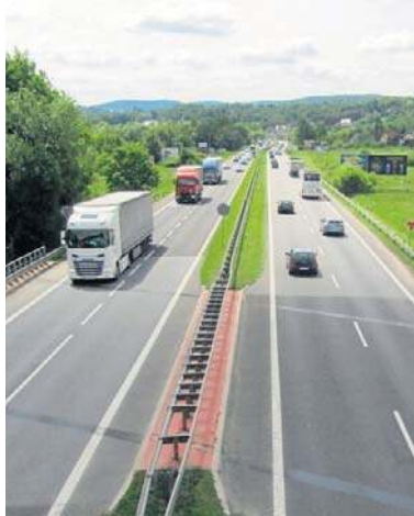
Drogi wzdłuż zakopianki będą modernizowane
