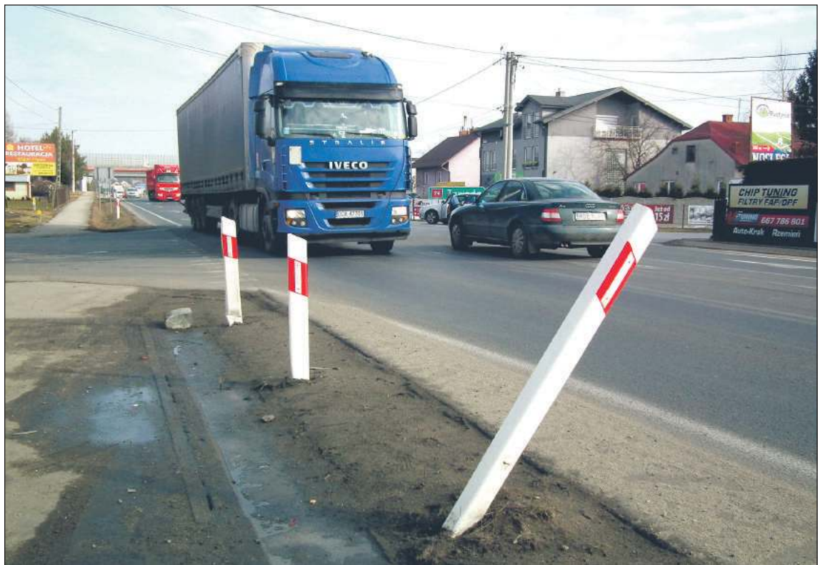
Mieszkańcy Pustyni od lat domagają się budowy ronda w miejscu feralnego skrzyżowania.
